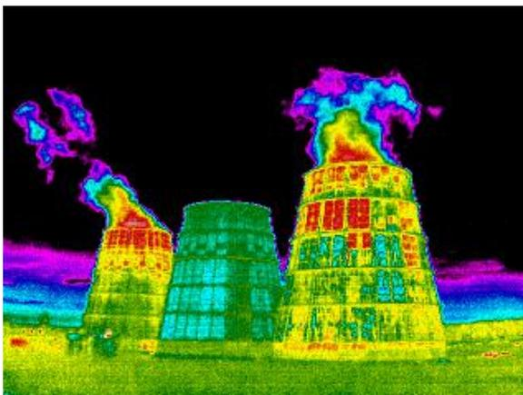
В процессе эксплуатации дымовой трубы могут быть нарушены проектные параметры: переход на другой вид топлива или уменьшение количества подключенных к трубе котлов. Изменение проектных параметров приводит к изменению перепада давления между наружной и внутренней средой, смещению точки росы внутрь ствола и усилению коррозионных процессов.
